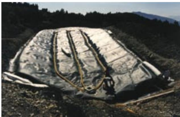
Superficie di captazione delle acque meteoriche in località Monticello, Comune di Vigo di Ton, in costruzione
